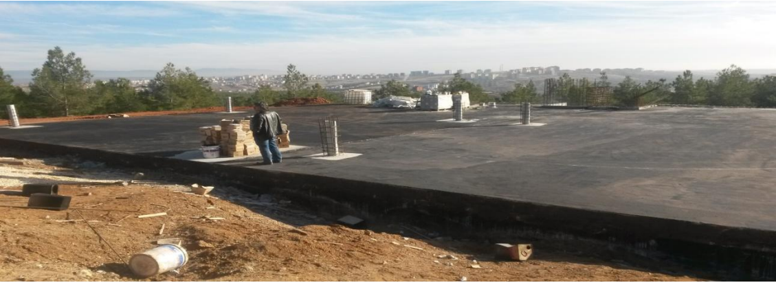
HACIKADEM ÇAMLIĞI 2000 M3 LÜK SU DEPOSU İNŞAA
