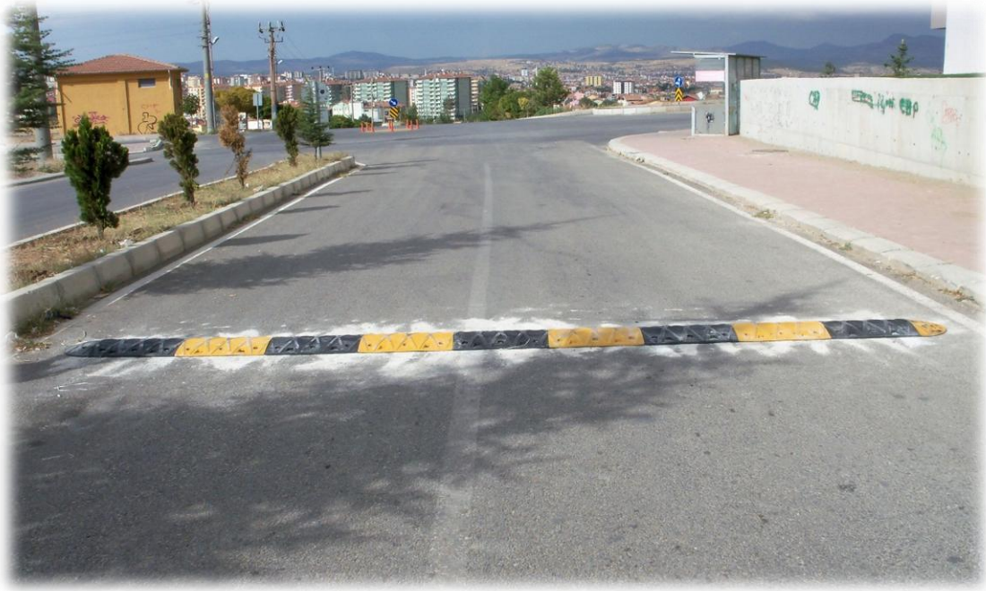
Hız Kesici Set Yapım Çalışması
