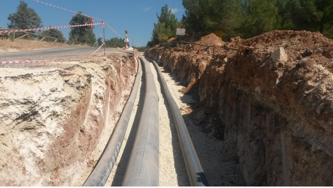
HACIKADEM ÇAMLIĞI 2000 M3 LÜK SU DEPOSU İNŞAATI
